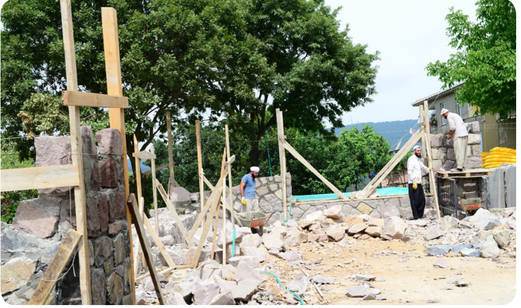
Mahmud Efendi Camii Şerifi Hanımlar Mescidi taş duvarlarının inşaat aşaması
